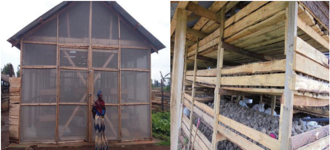
Sahani ya 5.4: Maghara ya gharama nafuu ya kuhifadhia viazi mviringo. (Picha: na Owekisha Kwigizile, TARI Uyole).
